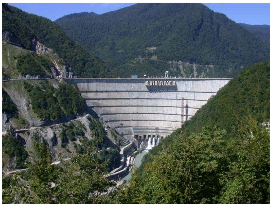
Рис. 1. Общий вид Ингурской плотины с нижнего бьефа
