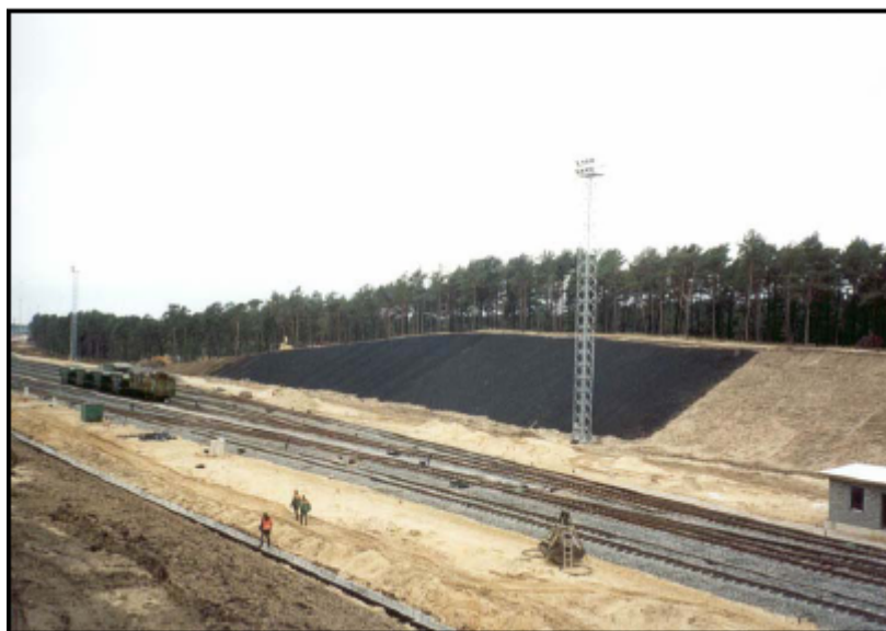
Рис.3. Защита железнодорожной магистрали от эрозионных процессов с помощью "Секумата"
